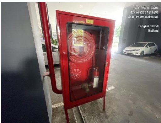
รูปที่ 48 ตู้เก็บสายฉีดน้ำดับเพลิงพร้อมอุปกรณ์และป้ายแนะนำการใช้งาน
