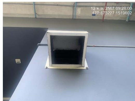
รูปที่ 38 ระบบระบายอากาศในห้องพักมูลฝอย
