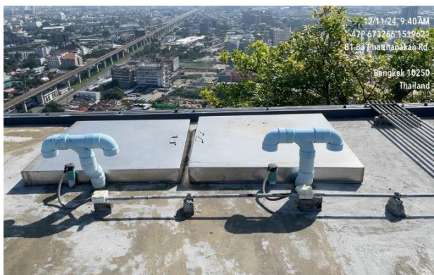
รูปที่ 16 ถังสำรองน้ำใช้ (ชั้นดาดฟ้าและชั้นใต้ดิน)
