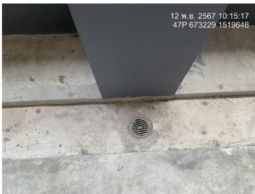
รูปที่ 74 ตะแกรงครอบรูท่อระบายน้ำ
