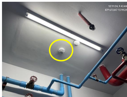
รูปที่ 53 เครื่องตรวจจับควันและความร้อน
